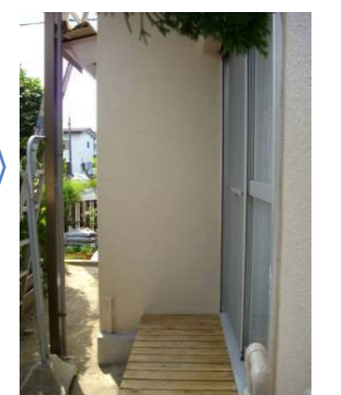
・モルタル、塗装にて完了
