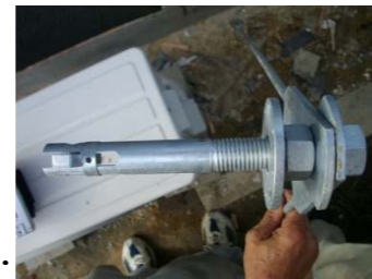
・ボルト、ブレース組付け状態
