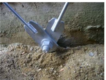
・基礎取付け部
