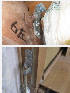
柱頭柱脚補強
