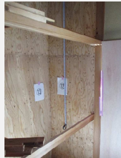
柱頭柱脚補強
